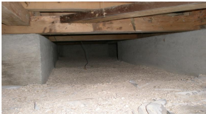
珪藻頁岩巻いた後、直後水分吸収状況
