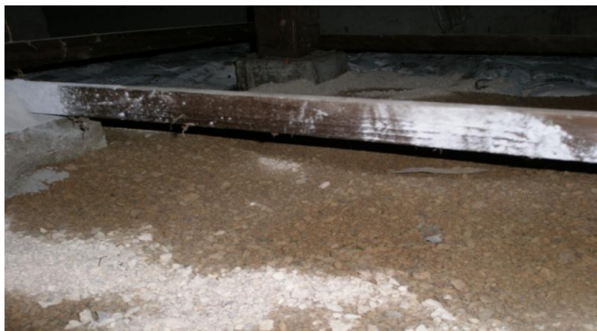
珪藻頁岩巻いた後、直後水分吸収状況
